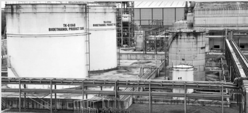
● Một góc Nhà máy Ethanol Bình Phước.
