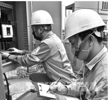
● Công tơ điện tử giúp hạn chế các vụ trộm cắp điện.
