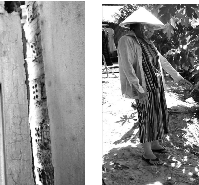
●Theo địa phương, cần xây dựng bờ kè cứng dọc khu dân cư để chống xói lở.
