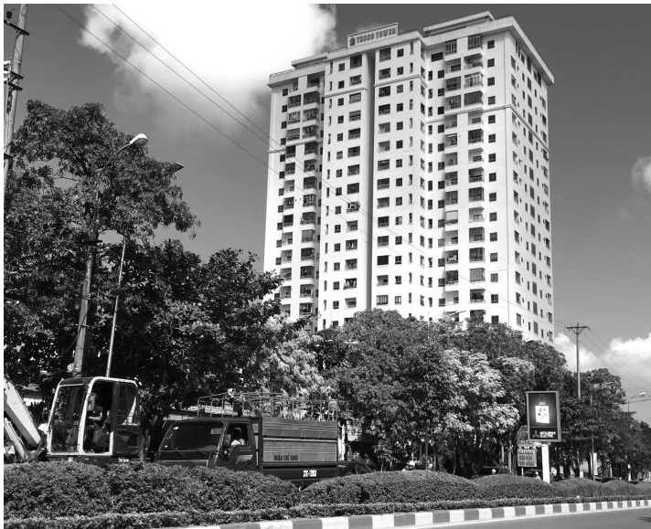
● Chung cư Tecco 215 tại phường Lê Lợi là một trong số những chung cư chậm bàn giao phí bảo trì.
