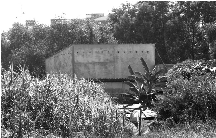
● Chủ đầu tư cho rằng năm 2020 con của bà Huệ lại xây dựng nhà không phép tại đất của dự án.
