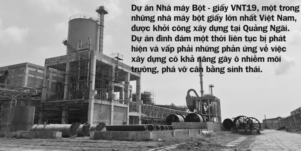
● Dự án Nhà máy Bột - giấy VNT19 đang xây dựng.
