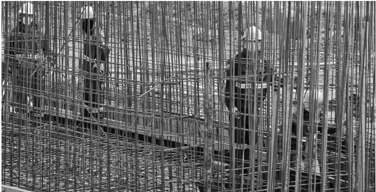
● Khu xử lý nước thải đang thành hình.
