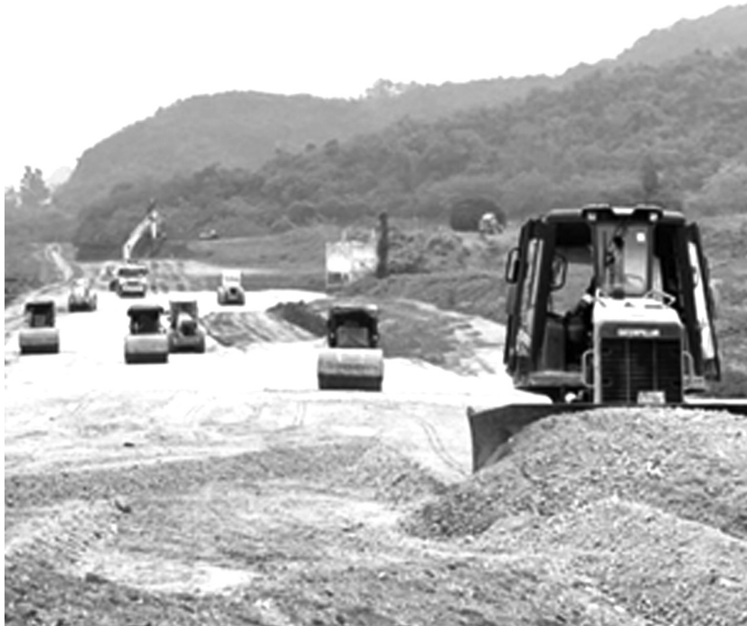
● Thi công cao tốc Bắc - Nam giai đoạn 2017-2020.
