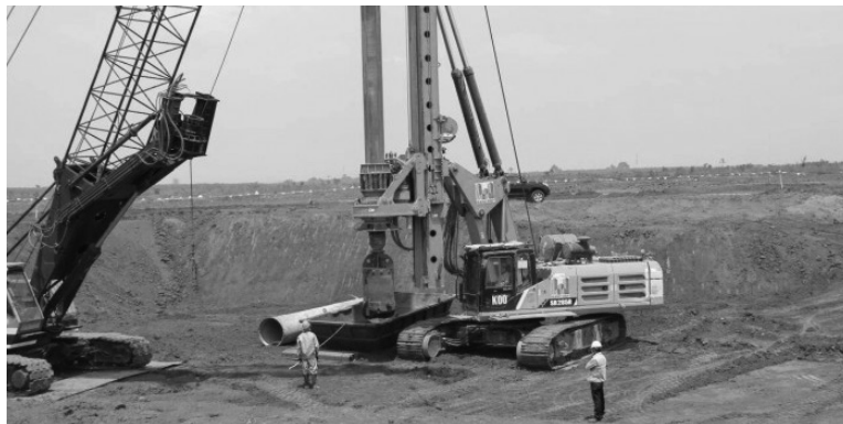
● Thi công đóng cọc nhà ga hành khách dự án sân bay Long Thành.
