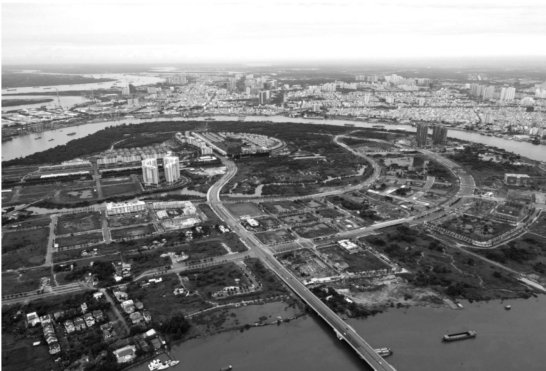
● TP HCM đã hoàn thành 34 nội dung theo kiến nghị của Ủy ban Kiểm tra Trung ương và Thanh tra Chính phủ về dự án Khu đô thị mới Thủ Thiêm.
