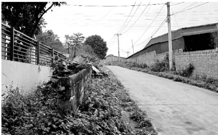
● Một phần công trình xây dựng vi phạm hiện nay.
