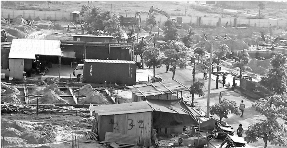
● Dự án KDC Thanh Hoàng vẫn có các hoạt động xây dựng dù cơ quan chức năng đã đề nghị dừng thi công.
