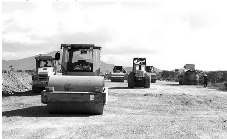
● Dự án thành phần cao tốc Bắc - Nam phía Đông đoạn Vinh Hào - Phan Thiết đang “chạy đua” tốc độ để kịp tiến độ.
