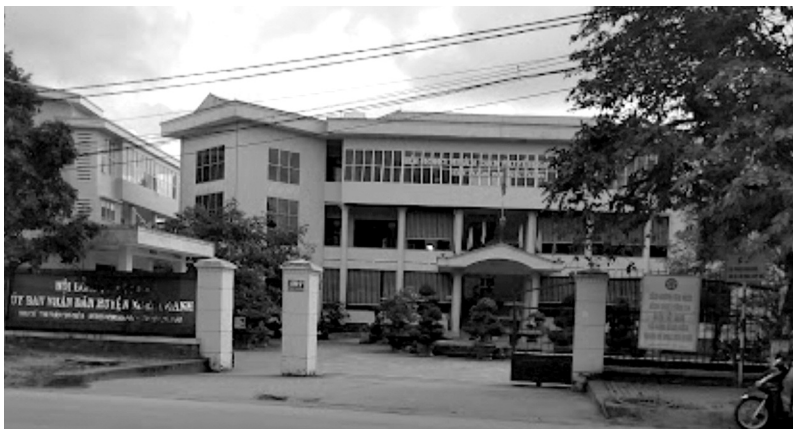
●Trụ sở UBND huyện Nghĩa Hành.
