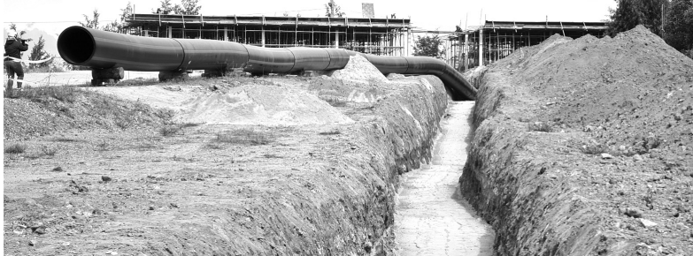
● Hiện trường thi công ống xả nước Nhà máy Bột - Giấy VNT19.
