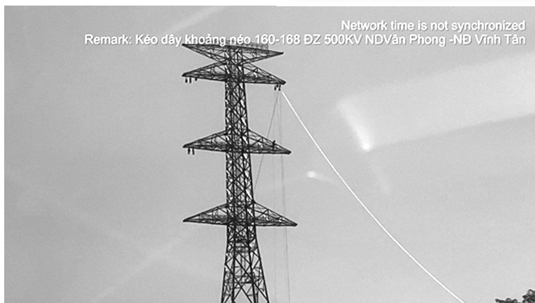
● Bắt đầu kéo dây đường dây 500 KV Vân Phong - Vĩnh Tân.
