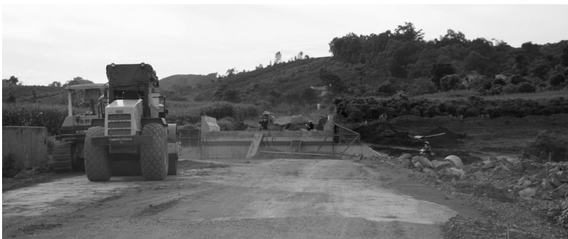
● Một đoạn dự án tuyển đường tránh TP Sơn La.
