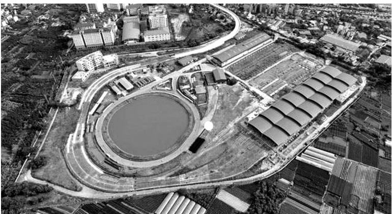
● Dự án đề pô đường sắt đô thị Nhổn - ga Hà Nội.
