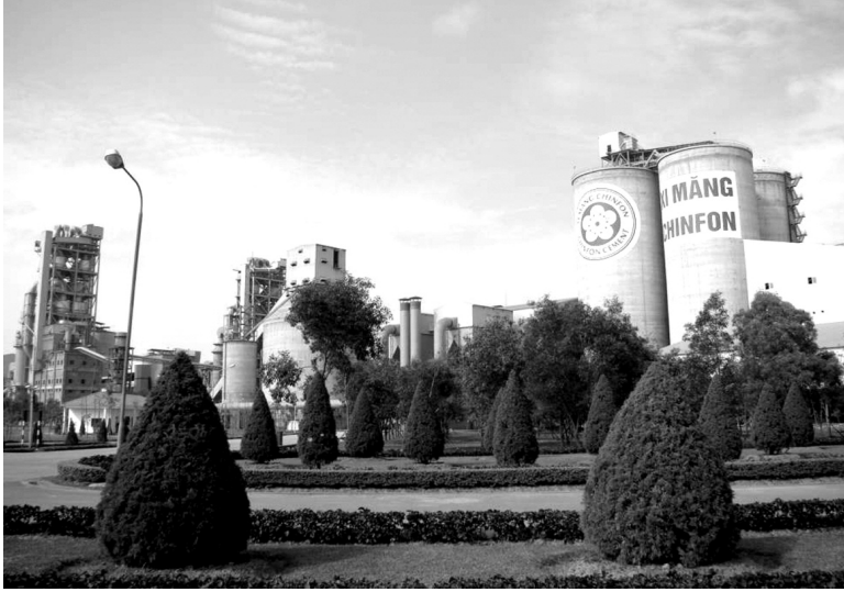
● Nhiều nhà máy xi măng đang nỗ lực thực hiện tiết kiệm năng lượng.
