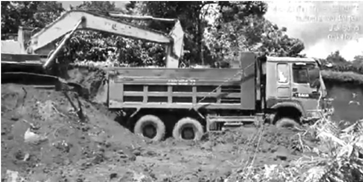
● Máy xúc đang đào mức đất tại thôn Đầm Giỏ.
