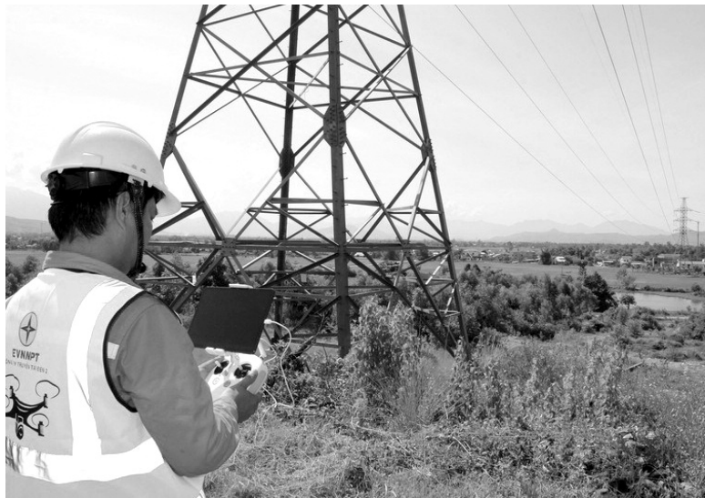
● Công nhân truyền tải điện điều khiển thiết bị bay không người lái để kiểm tra đường dây.
