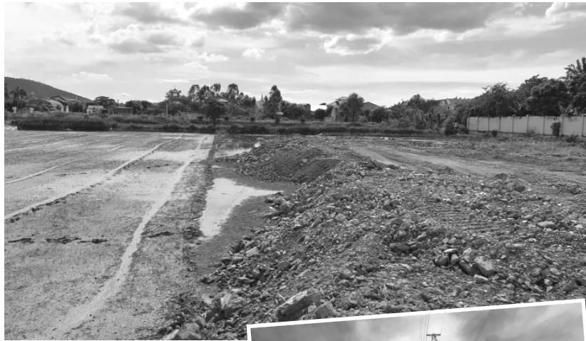
● Đất nông nghiệp bị san lấp trái phép.
